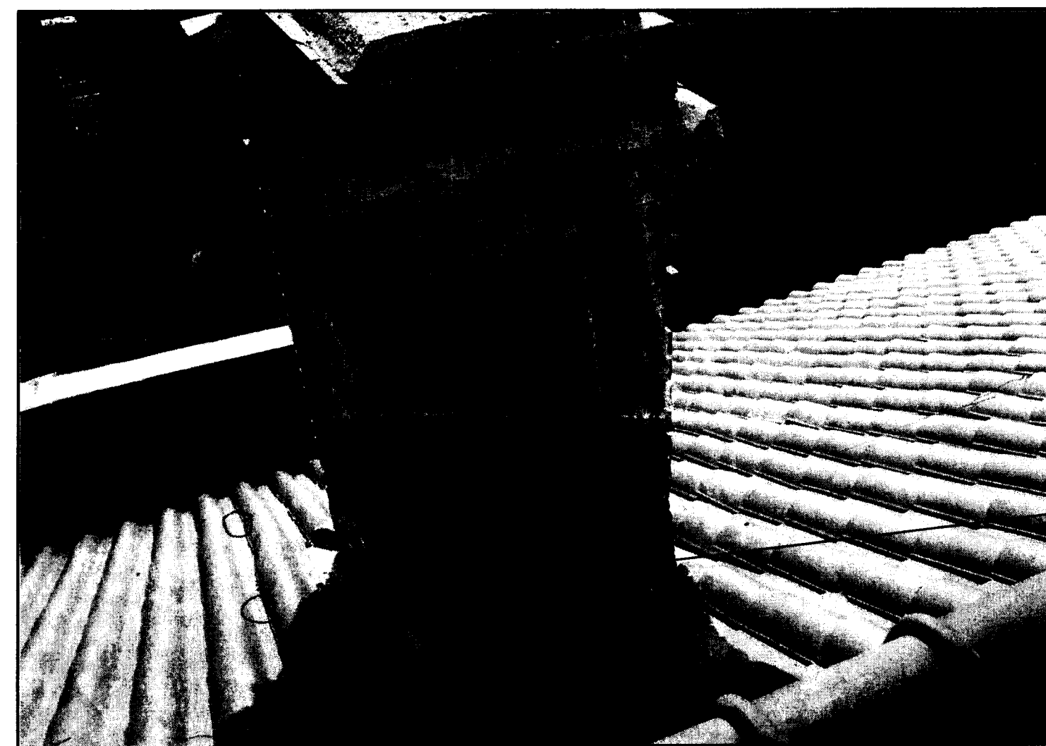
4 CHIMNEY PHOTO #1 SCALE: N.T.S.
